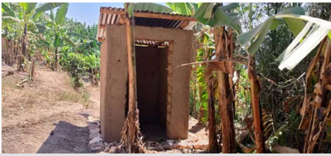
Eine von 27 Toiletten, noch in der Konstruktion
